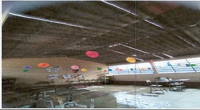
Foto 1: sustitución de lámina por lámina troquelada.
